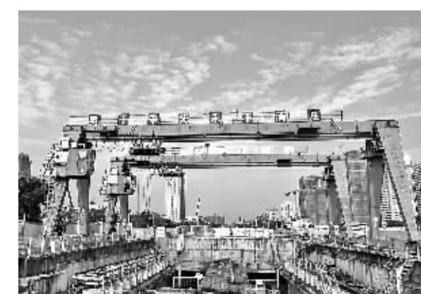
6月12日，在南宁地铁一号线施工现场，中铁四局八分公司施工人员开始对龙门吊等施工辅助设备进行拆除。据介绍，南宁地铁集团已对一号线子单位工程开始验收，并进入机电和装修施工阶段。
