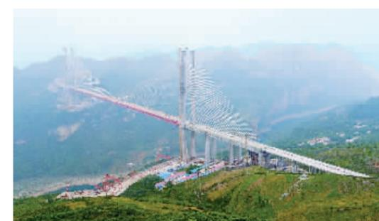
贵州高速鸭池河特大桥5月20日成功合龙。鸭池河特大桥是贵州高速公路控制性工程,为双塔索面混合式钢桁梁斜拉桥,主桥长1460米,主跨800米,是贵州省跨径最大的钢桁梁斜拉桥。
