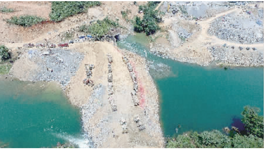
5月18日,《左右江革命老区振兴规划》中重点能源建设项目瓦村水电站工程截流成功。该项目位于广西田林县境内,总投资25亿元,以发电为主,兼顾供水、防洪、航运等综合利用。图为工程截流施工现场。 韦万忠摄(新华社发)
