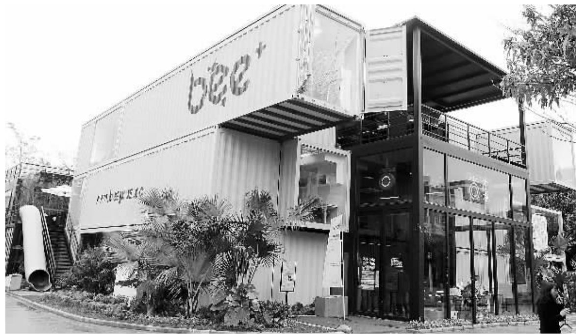
全国首家以集装箱为建筑形态的Bee+联合办公空间在珠海软件园开张。Bee+用36个集装箱拼叠搭建而成,占地600平方米,是一个集联合办公空间、文化活动策划、青年社群于一体的创新青年业态。(资料图片)
