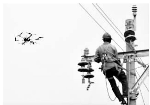
4月28日,受持续降雨影响,湖北宜昌市夷陵区分乡镇高场村五组陈家湾地质灾害监测点滑坡变形明显加剧,导致电力设施受损,供电公司利用无人机跨越险区展放送电线路牵引绳,大大缩短了抢修时间,快速恢复了供电。张国荣摄
