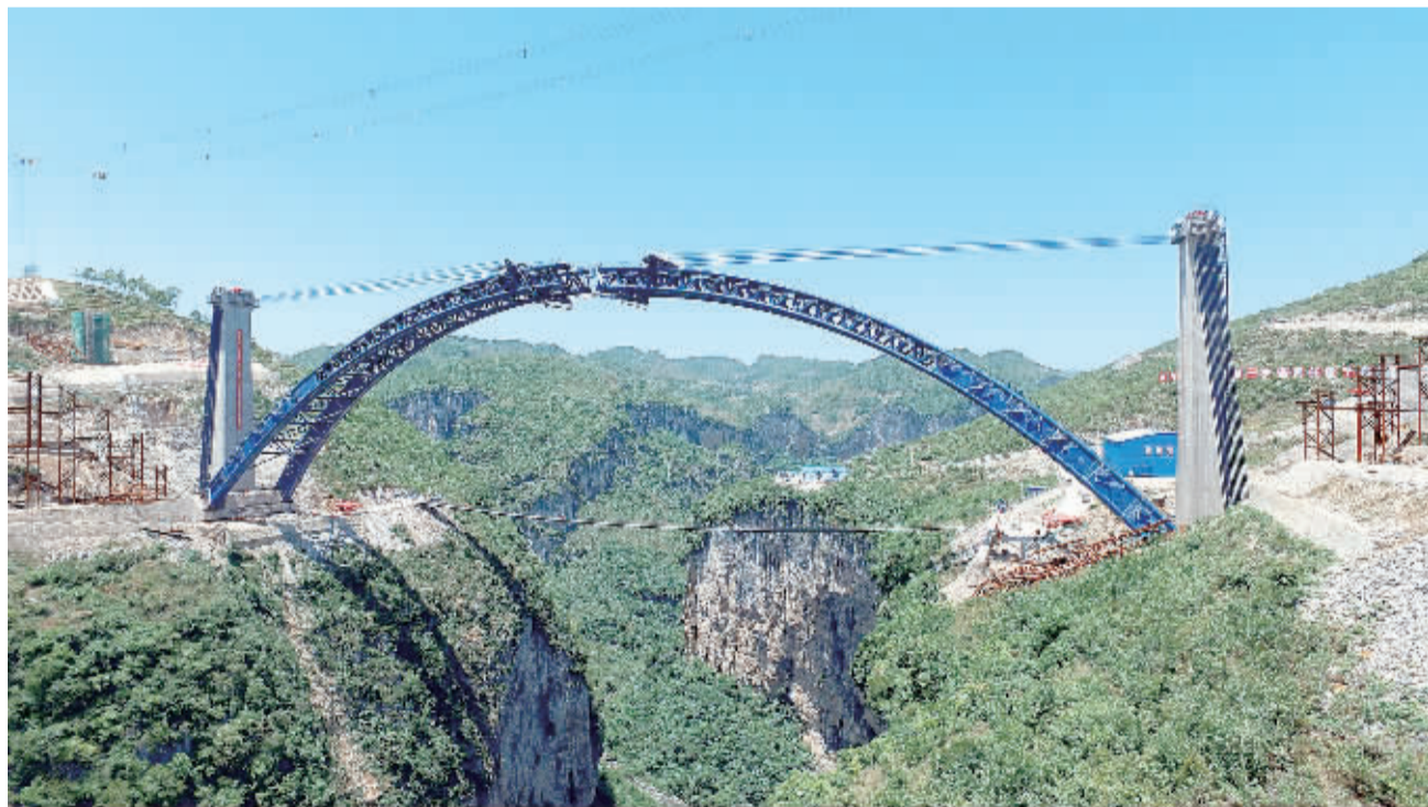
图为即将合龙的西溪河大桥。5月11日,我国高铁首座钢管混凝土转体拱桥,成都至贵阳高速铁路的重难点控制性工程——西溪河大桥顺利实现转体合龙,为成贵铁路按计划建成通车奠定基础。王会堂摄(新华社发)
