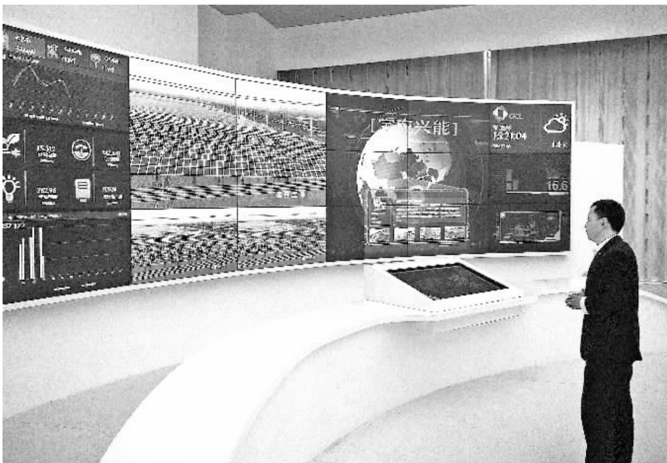
在协鑫能源管理中心，可实时监控其分布在全国各地光伏电站的发电量。
