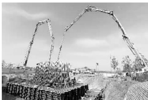
4月17日，中铁上海工程局集团济青高铁项目部员工正进行承台混凝土浇灌。济青高铁是国家“四纵四横”快速铁路网的重要组成部分。 张华先摄
