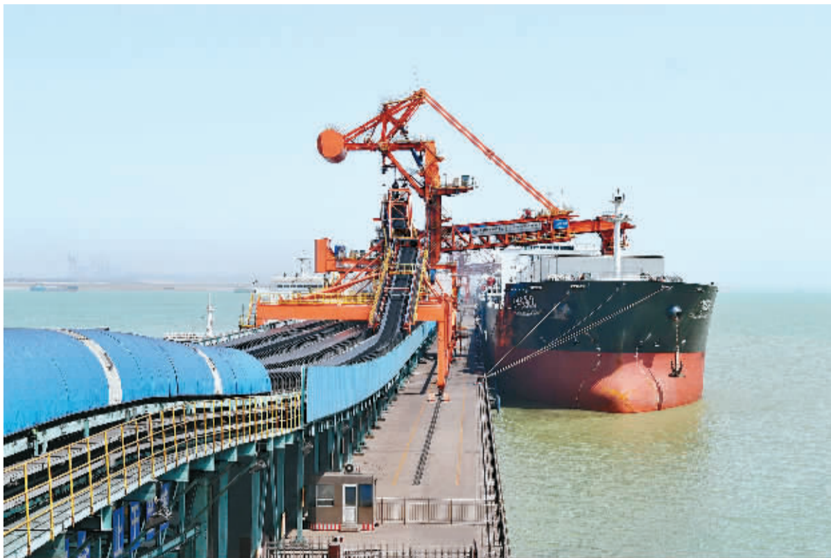
河北黄骅港一季度累计完成煤炭吞吐量4279.37万吨,同比增长100.39%,创开港运营以来历史同期最高纪录。图为4月14日,轮船靠泊在黄骅港煤炭码头装货。
