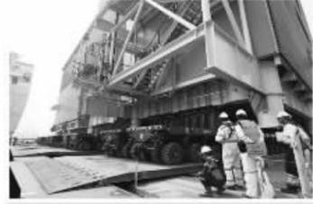
SPMT 小车承载模块缓缓通过栈桥,驶向驳船甲板。 韩庆摄
