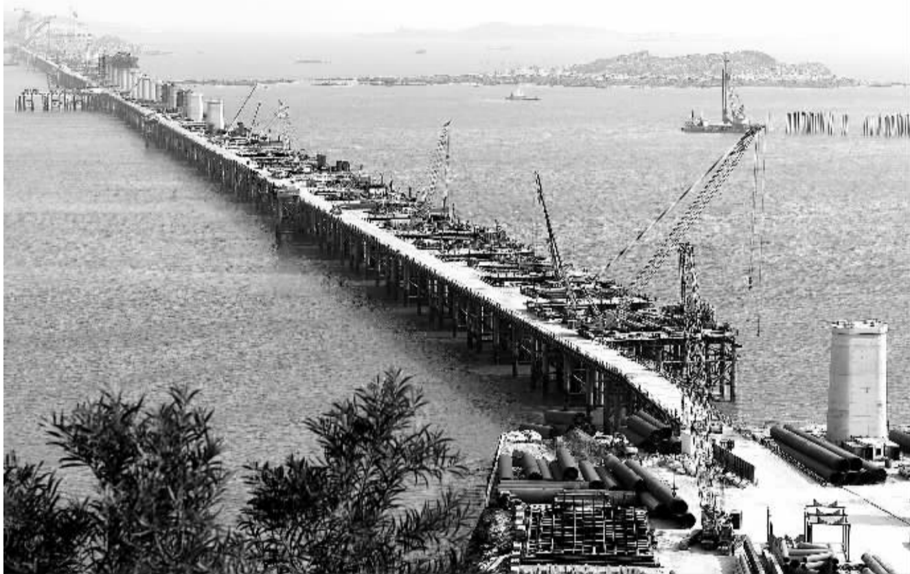
福州)平(潭)铁路平潭海峡公铁两用跨海大桥起于福建省长乐市松下镇,全长16.34公里,经过四座岛屿后到达平潭岛。该桥采用双层桥面,上层是六车道高速公路,下层是可供动车组列车行驶的双线铁路。大桥目前正在紧张施工中,预计2019年建成通车。这是建设中的平潭海峡公铁两用跨海大桥(4月6日报)。
