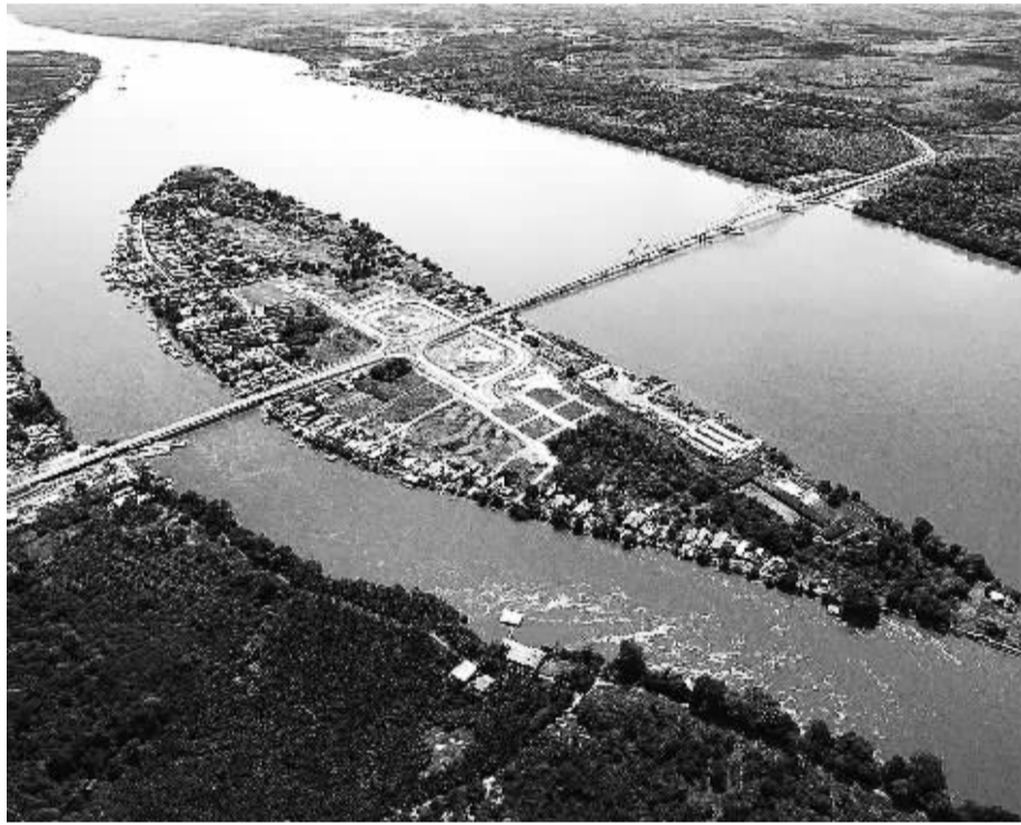
由中国路桥工程公司承建的印度尼西亚西加里曼丹省塔扬桥3月22日正式通车。塔扬桥位于印尼西加里曼丹省首府坤甸以东100公里,桥梁总长度为1350米,设计时速为80公里,桥梁结构设计使用寿命为100年。图为塔扬桥全景。 新华社发
