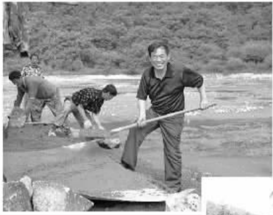
▲2009年7月9日,毛丰美在大梨树龙潭水域网改造现场。(资料图片)
