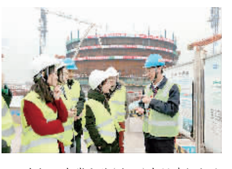
本报记者崔文苑(左一)在福清核电站施工现场了解绿色信贷。 林雪梅摄
