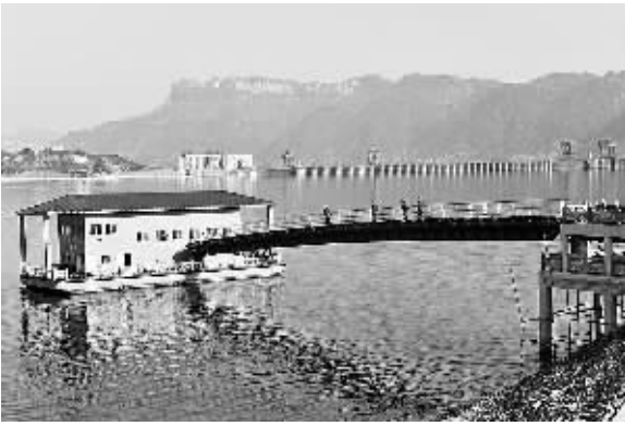
2月16日,三峡坝前首座泵船式取水泵站搭建完成。这种取水泵站由船舶和万向活络接据输水管组成,会随着三峡库区水位的涨落而自由移动,解决了缆车取水移动频繁耗时长的问题,为三峡库区移民生产生活用水提供保障。图为泵船式取水泵站。 郑家裕摄 (新华社发)
