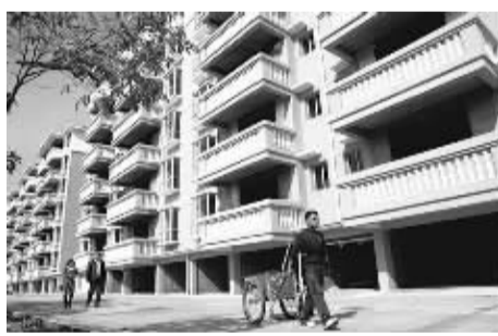
近日,工人在江西省靖安县雷公尖垦殖场场山安置小区清运建筑垃圾。近年来,江西省实施农垦危房改造工程,帮助农垦人搬进城镇新区。徐仲庭摄(新华社发)
