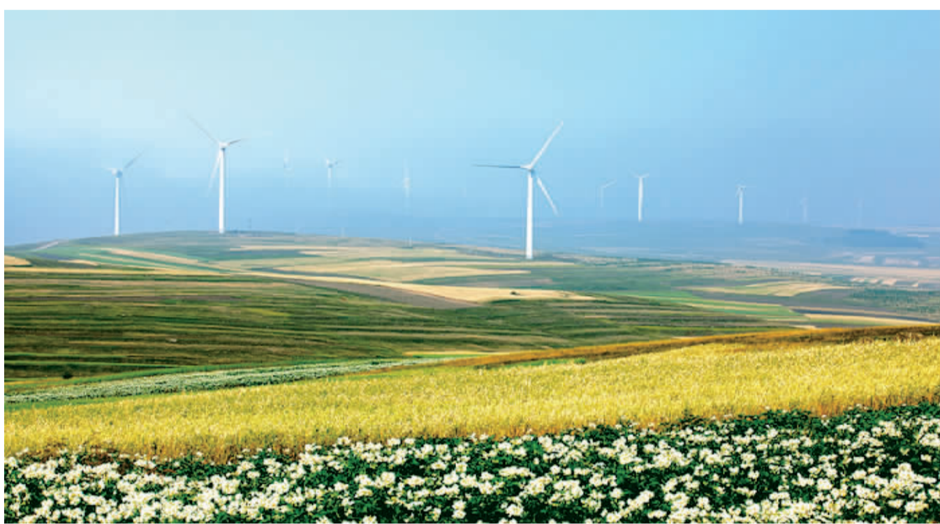
坐落于河北张家口国家风光储输示范工程自2011年底建成投运,已累计输出超过17亿千瓦时平稳可控的绿色电能。图为国家风光储输示范工程现场。(资料图片)
