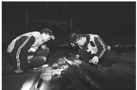
正月初二,京沪高铁黄河特大桥的探伤工们正在认真检查线路。0时30分至4时30分,4个小时的维修天窗里,探伤工们借助微弱的头灯,俯身推行几十公斤探伤仪器,完成6公里的钢轨探伤作业,确保列车大动脉的安全。 本报记者 王金虎摄
