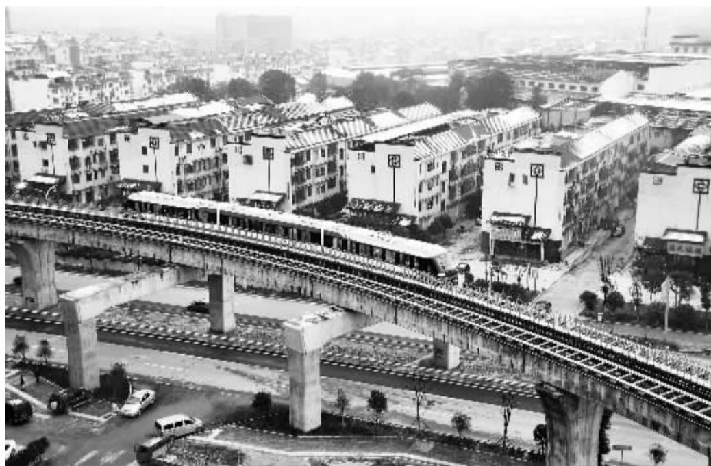
这是上线试运行开展系统调试的长沙磁浮快线(2月2日摄)。连日来,中国首条拥有完全自主知识产权的中低速磁浮铁路——湖南长沙中低速磁浮快线上线调试工作继续进行,为春节后列车试运营做冲刺准备。这条磁浮快线连接长沙火车南站和黄花机场,全长18.55公里,全程高架敷设,于2014年5月开工建设。
