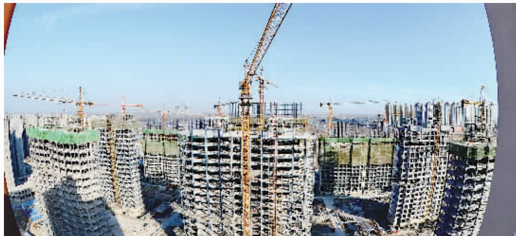
图为河北省沧州市福康家园保障房项目施工现场。
