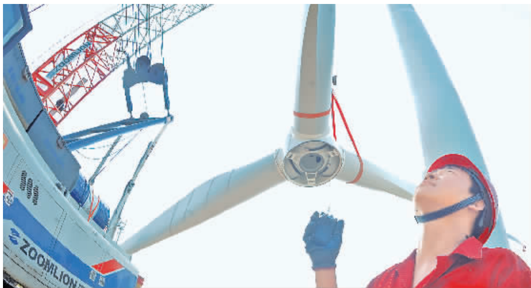
施工人员在江苏扬州菱塘回族乡境内的低风速风电场吊装风机。
