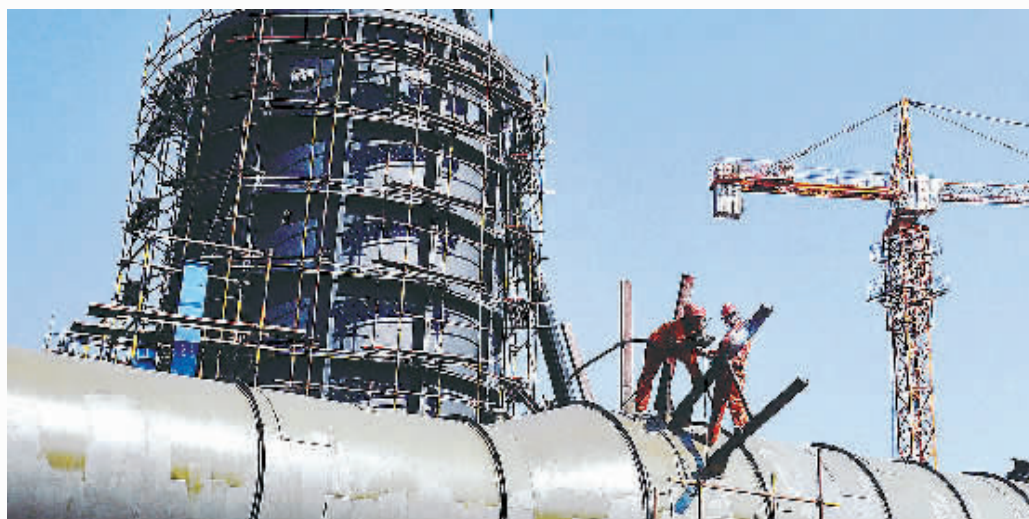
吉化建修车间工人对输油管道进行维修。
