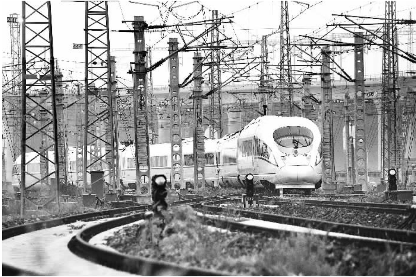
京沪高速铁路开通运营以来，京沪高铁基础设施状态良好，运量快速增长，安全有序可控。图为—列开往上海虹桥方向的动车组列车在轨道上行驶。
