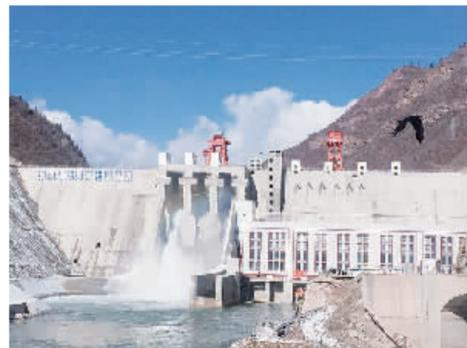
12月27日,一只雄鹰飞过即将建成发电的果多水电站大坝。西藏昌都规划在金沙江、澜沧江、怒江三江流域干支流上建设总装机容量3585万千瓦的49座梯级电站。果多水电站位于澜沧江上游支流扎曲河上,工程总投资38.33亿元,建设总装机容量16.5万千瓦,年发电量8.319亿千瓦时,是西藏在建的装机容量第二大电站。
