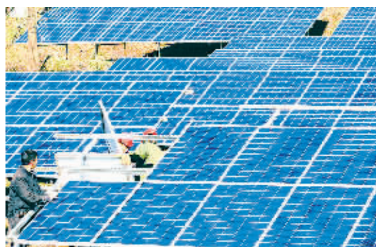
12月17日,江西遂川县零田镇荒山坡上,工人在太阳能光伏发电站紧张施工。据了解,该县去年引进投资10亿元的光伏发电项目,总装机约10万千瓦,预计建成后年利税可达2000万元以上。 李建平摄
