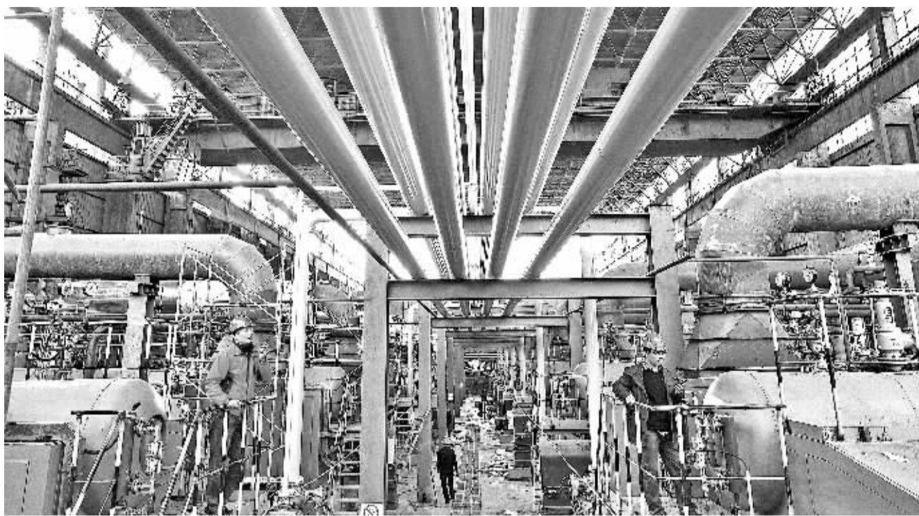
11月2日，河北省石家庄热电三厂关停替代项目现场，工作人员调试今年新安装的16台20吨燃气供热机组。今年石家庄新增供热面积823万平方米，将全部采用废热、天然气、热电联产等清洁能源。
