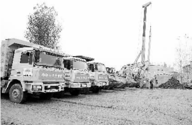
10月31日，在河南省平顶山市鲁山县辛集乡柴庄村，郑万高铁河南段开始施工。当日，郑州至万州高铁河南段开工仪式在河南省平顶山市举行。
