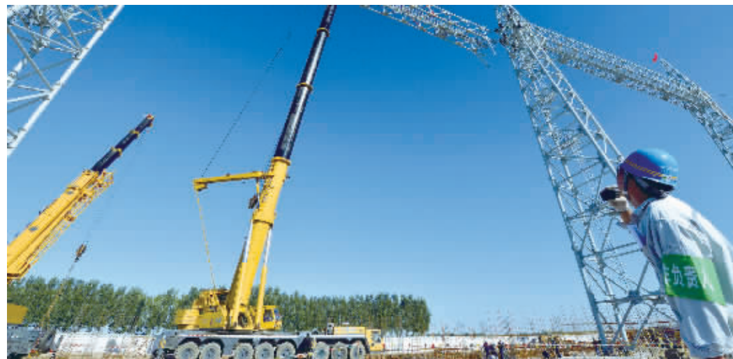
9月25日,在北京东1000千伏变电站施工现场,工程负责人在指挥吊装构架横梁。 新华社记者 李晚采摄
