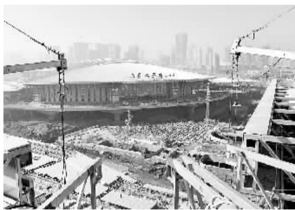
10月26日,工人正在全力建设乌鲁木齐高铁新客站。该站建筑面积11万平方米,预计2015年底北站房将具备投运条件。新华社记者 赵戈摄
