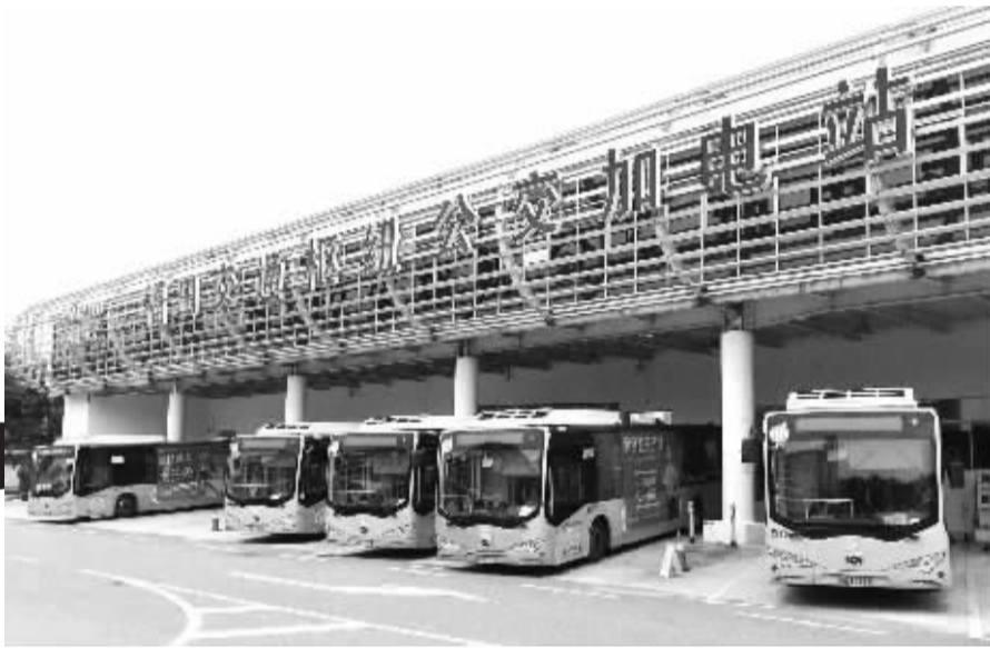
左图 深圳福田交通枢纽充电站。
