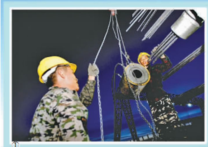
①西环高铁施工现场。
