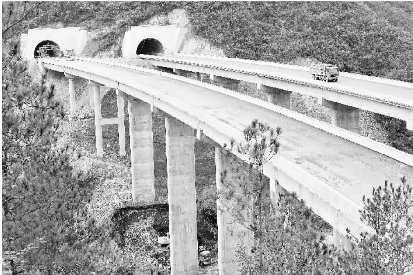
10月3日，一辆施工车行驶在湖北省麻竹高速公路康保县城关段。目前，麻竹高速宜城至康保段建设进入收尾阶段。麻竹高速是横贯湖北省中北部的一条东西向省际通道，全长665公里，全线采用双向四车道，预计今年年底全线通车。 杨 轲摄
