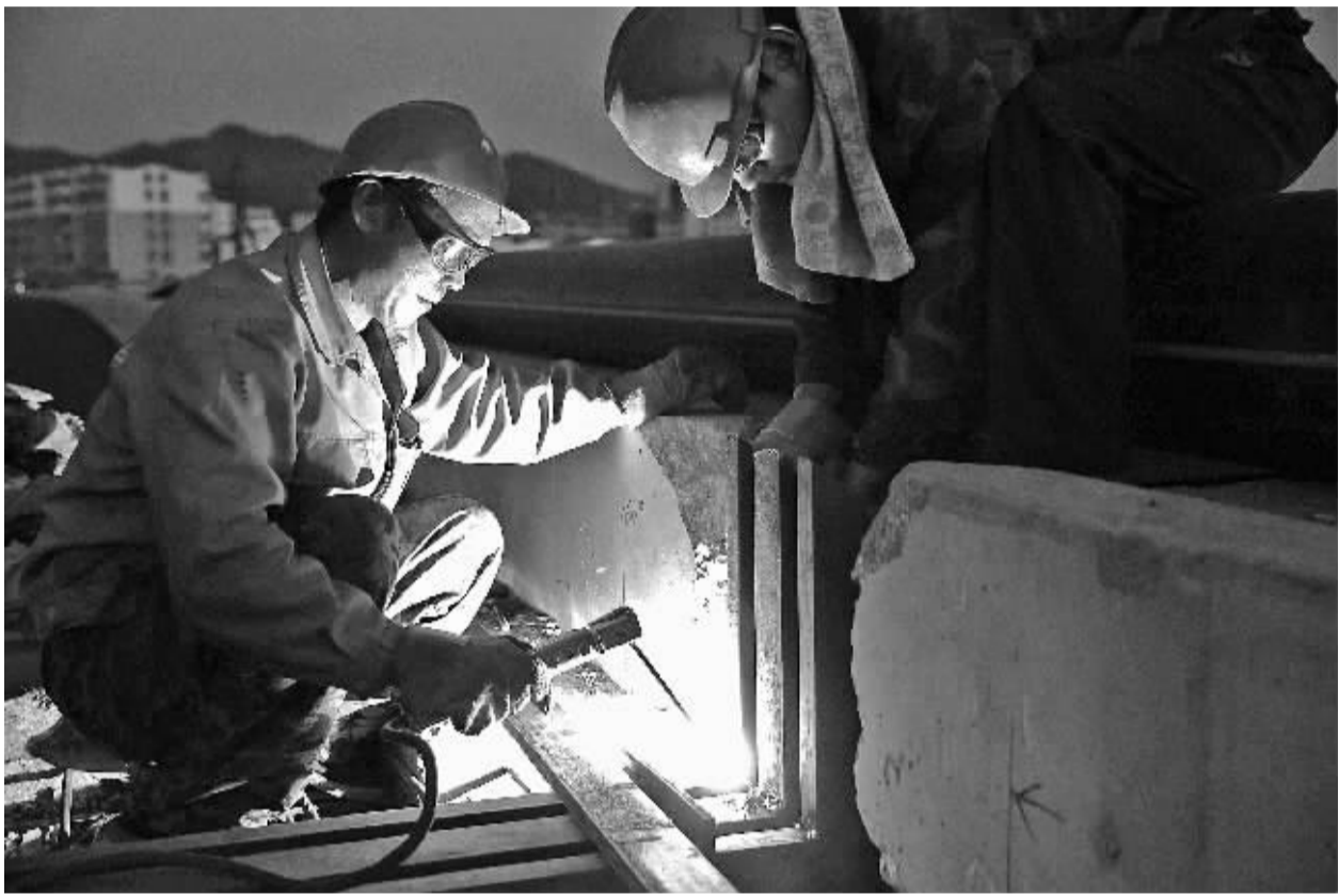
▲ 10月2日，江西省吉水县赣江二桥施工现场，来自河北衡水的老彭（左）和他的工友正在焊接桥梁伸缩缝。为赶在10月底顺利竣工通车，负责桥面铺装工人们放弃休假，抓紧赶工。 许祖平摄
