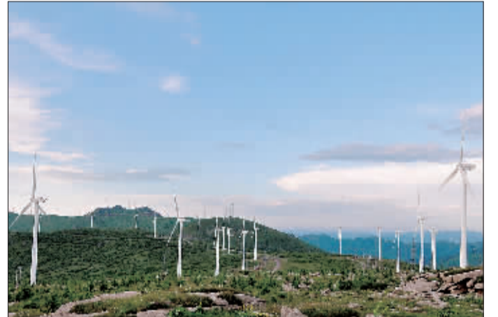
河北赤城冰山梁发电场辽阔壮美,众多的风力发电机正在源源不断地提供着清洁能源。申贵飞摄
