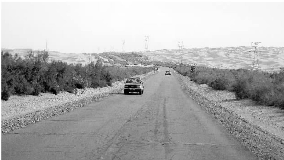
塔克拉玛干沙漠腹地，绿色的防护林带让沙漠公路免于被流沙侵蚀。
