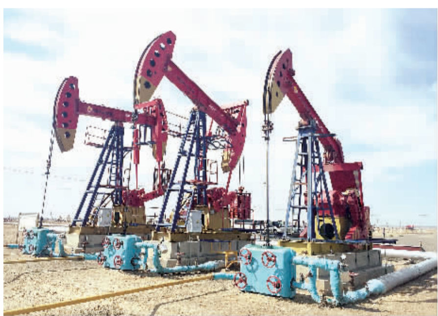
新疆油田公司采油井正在作业。
