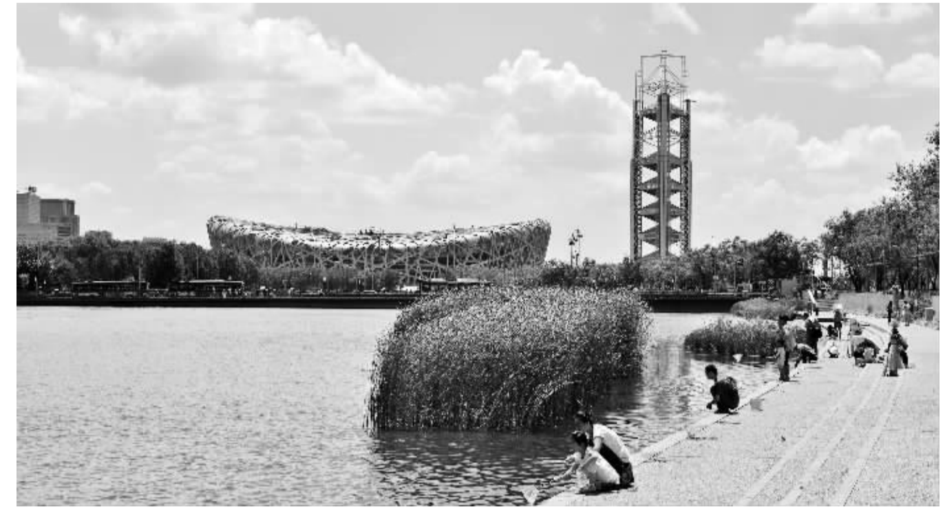
北京国家体育场和奥林匹克森林公园运用海绵城市建设理念，地下暗藏排水设施。 李鑫摄（新华社发）
