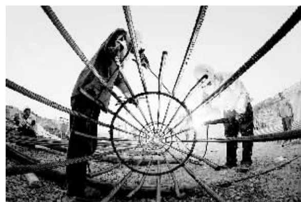
9月4日,陕西西安中铁上海工程局集团第七分公司员工正在地铁四号线工地紧张地焊接钢筋笼,该线路部分站点开始铺轨。按照规划,西安地铁四号线将于2018年建成运营。 张华先摄
