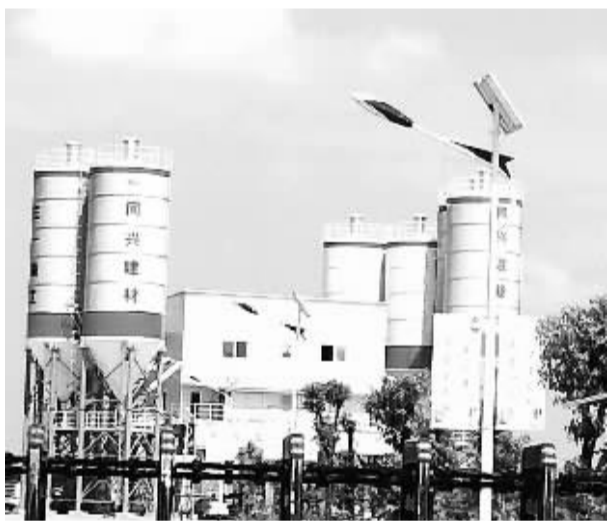
图为同兴公司未批先建的生产线。本报记者 刘麟摄
