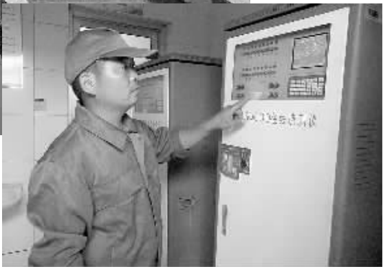
上图:四川是泡菜大省,许多泡菜企业产生大量污水,川南酿造有限公司建设污水处理系统处理污水。 右图:四川蒙牛乳业(眉山)有限公司利用COD在线速测仪对污水处理进行实时监控。
