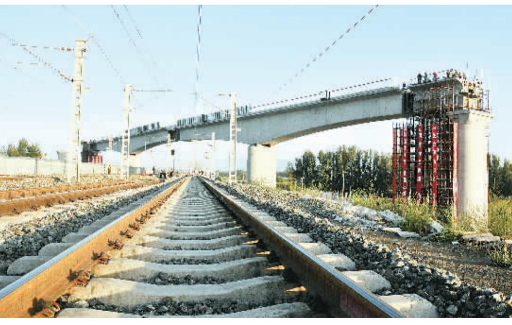
8月20日,呼准鄂铁路跨呼准铁路特大桥转体施工完成。
