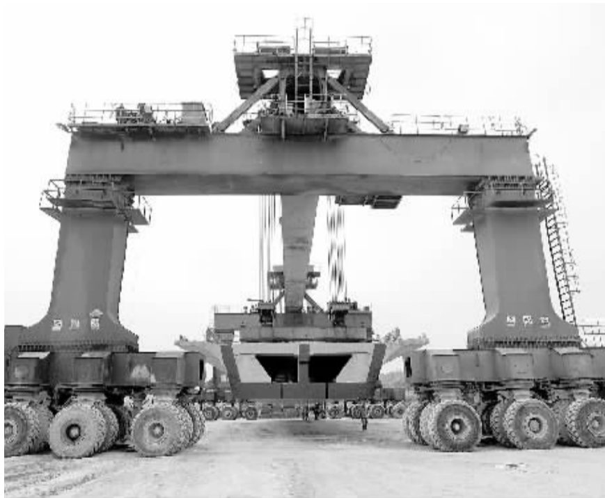
图为中铁四局五公司的施工人员在武九客运专线庐山段的工地上吊运箱梁。武九客运专线起于武汉站,经湖北省鄂州市、黄石市、阳新县、江西省瑞昌市、九江县,利用昌九城际铁路接入九江站。
