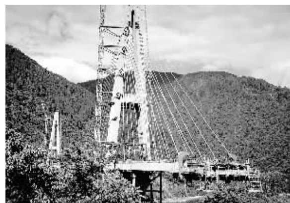
图为西藏林芝市“迫龙沟大桥”施工现场。该工程自2012年10月开工以来,经过建设者近3年的艰苦努力,隧道和路基工程现已完成,预计今年9月30日大桥合龙,12月30日全线通车。
