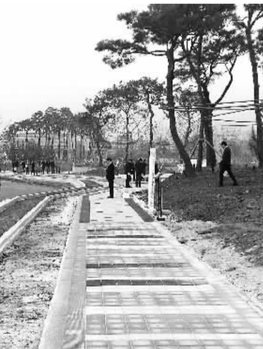
韩国首尔文井地区进行的人行道透水性改造示范工程现场。 本报驻首尔记者 杨明摄
