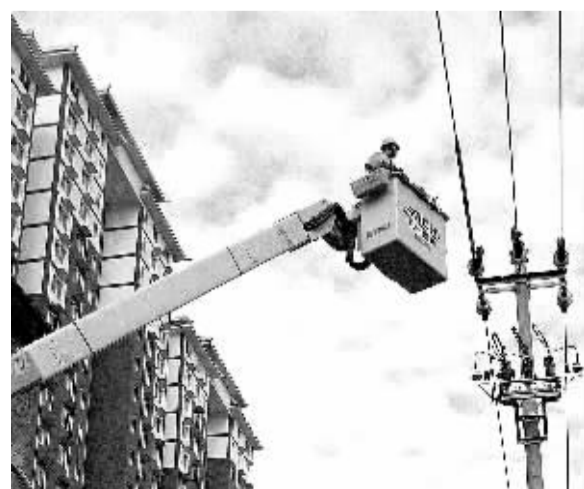
7月28日，国网陕西汉中供电公司职工正在作业。连日来，陕西气象部门持续发布高温橙色预警信号，汉中盆地更是迎来今年入夏以来最高气温。为最大限度减少因施工作业停电对客户带来的影响，员工对设备进行检修，确保供电。 周游摄
