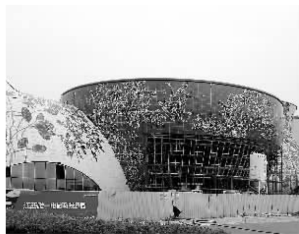
江西南昌青花瓷群万达广场项目已初具雏形。该项目由中建二局承建,预计2016年5月开业运营,建成后将成为当地文化旅游产业的新引擎和新亮点。图为万达广场一角。 吴光波摄
