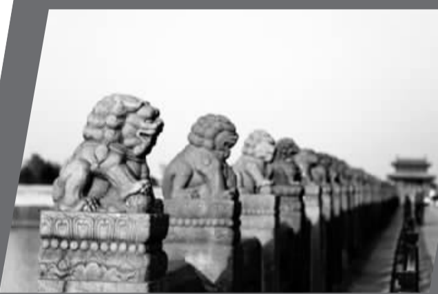
卢沟桥 资料照片
