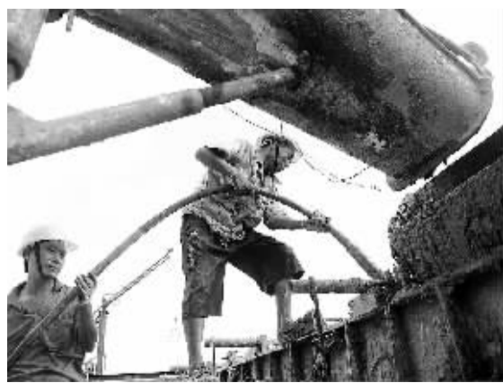
6月10日,中铁隧道集团工人正在江罗高速新开工现场紧张施工。该道路是国内首条连接“珠三角”和广西的高等级公路。目前,该工程已完成总体进度的70%,先行段计划今年年底通车。
