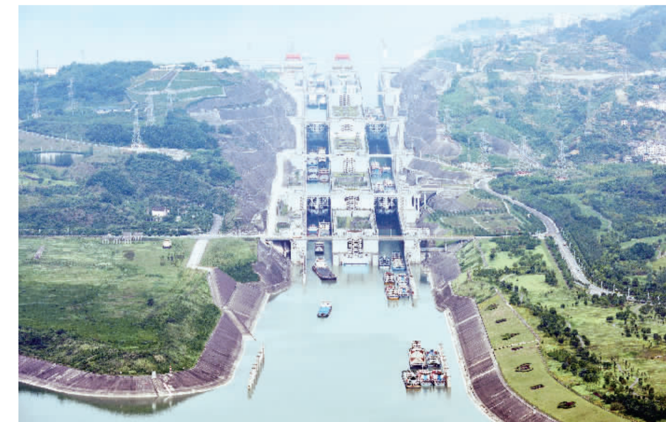
5月30日拍摄的长江三峡五级船闸。近日,据中国长江三峡集团公司及长江三峡通航管理局相关负责人介绍,今年1至4月,三峡船闸的累计通过货运量逾3428万吨,与去年同期相比上升5.77%,再创新高。
