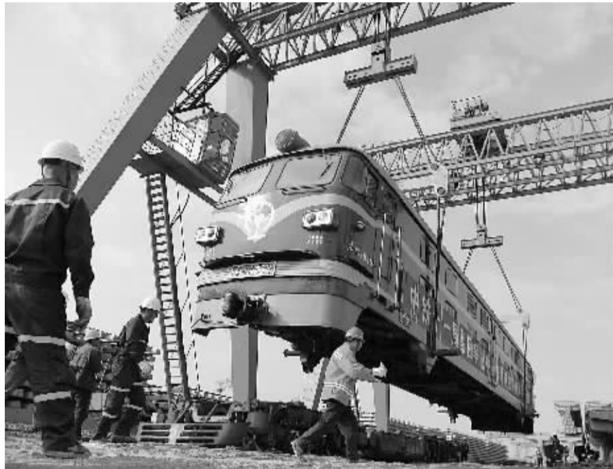
图为施工人员在大连丹大铁路施工现场将东风4型0458号火车头重新组架。日前，东风4型0458号火车头通过铁路、公路、轮渡等多种交通方式运抵丹大铁路施工现场，投入建设任务。
