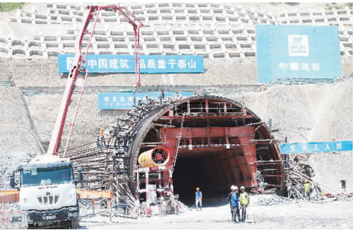
中国建筑股份有限公司承建阿尔及利亚南北高速公路53公里长的希法段。这是阿尔及利亚基础设施领域最艰难施工的一个项目,也是阿尔及利亚南北高速公路最重要的一段。项目全长53公里,其中隧道4.8公里,桥梁40座。图为中国建筑股份有限公司员工在阿尔及利亚南北高速公路希法段开凿隧道。新华社发
